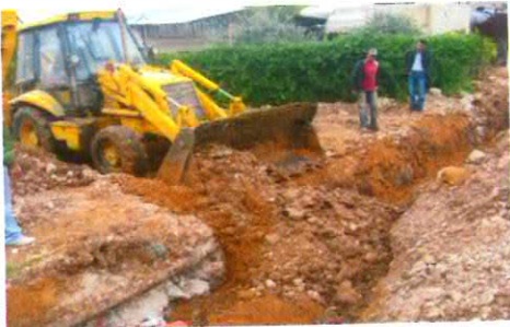
Excavation work –Habla
