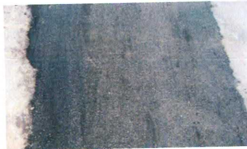
Asfalt work – Habla
